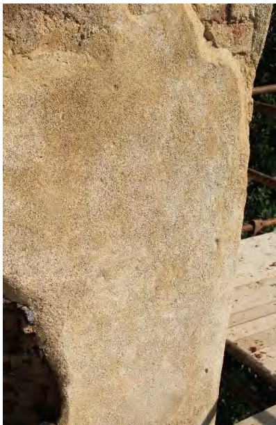
Abbildung 6: Putz nach zweimaliger Behandlung mit CaLoSiL® E25.
